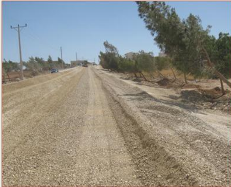
طريق الكرك (القصر - الموجب) المحطة : ١٠٠ + ٨ رش و خلط وفرد طبقة الـ BASE
