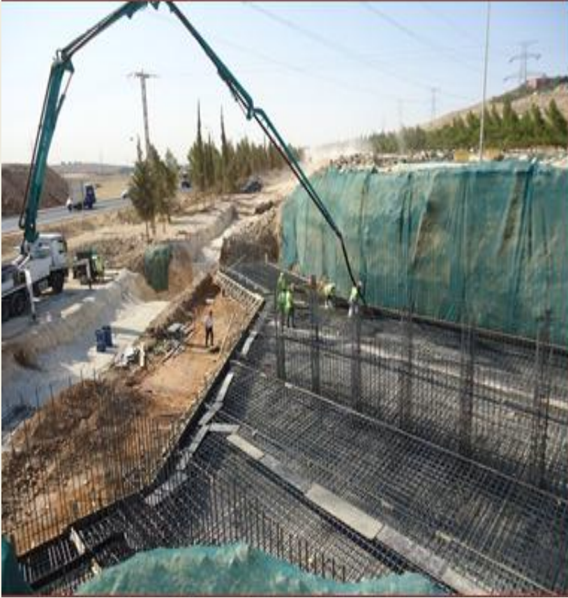
أعمال صب قواعد نفق الشويفات الجديد ٢٠١١-٩-٤
