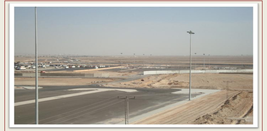
الجدار الأمني والجدار الخارجي اقليم الوسط بتنفيذ مباني مختلفة وأعمال طرق وساحات وبنية تحتية لمنطقة الشحن في مركز حدود العمري
