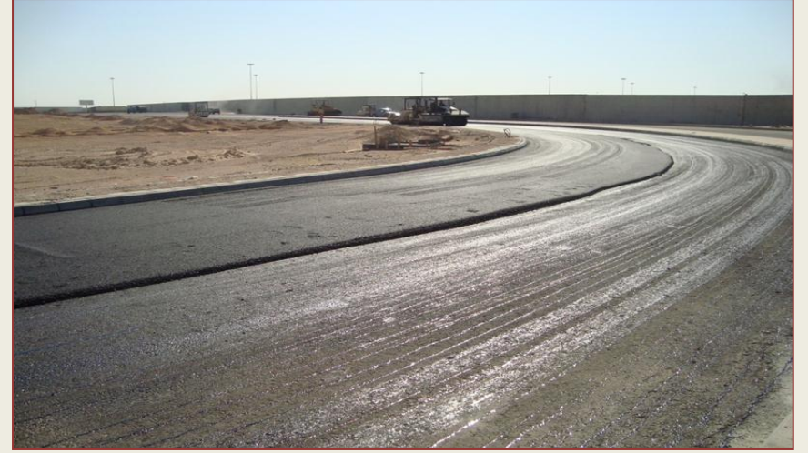
أعمال الاسفلت على طريق الربط رقم ٤
