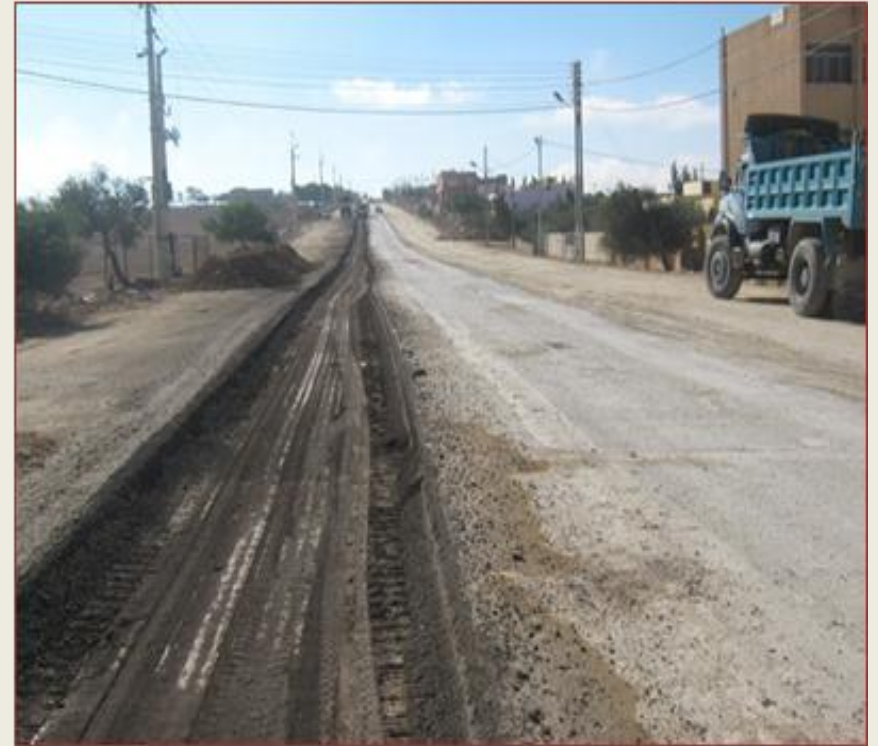
طريق الكرك ( القصر - الموجب ) المحطة ٩٠٠ + ١١ ازالة الخلطة القديمة تاريخ ٢٠١١/١/٦
