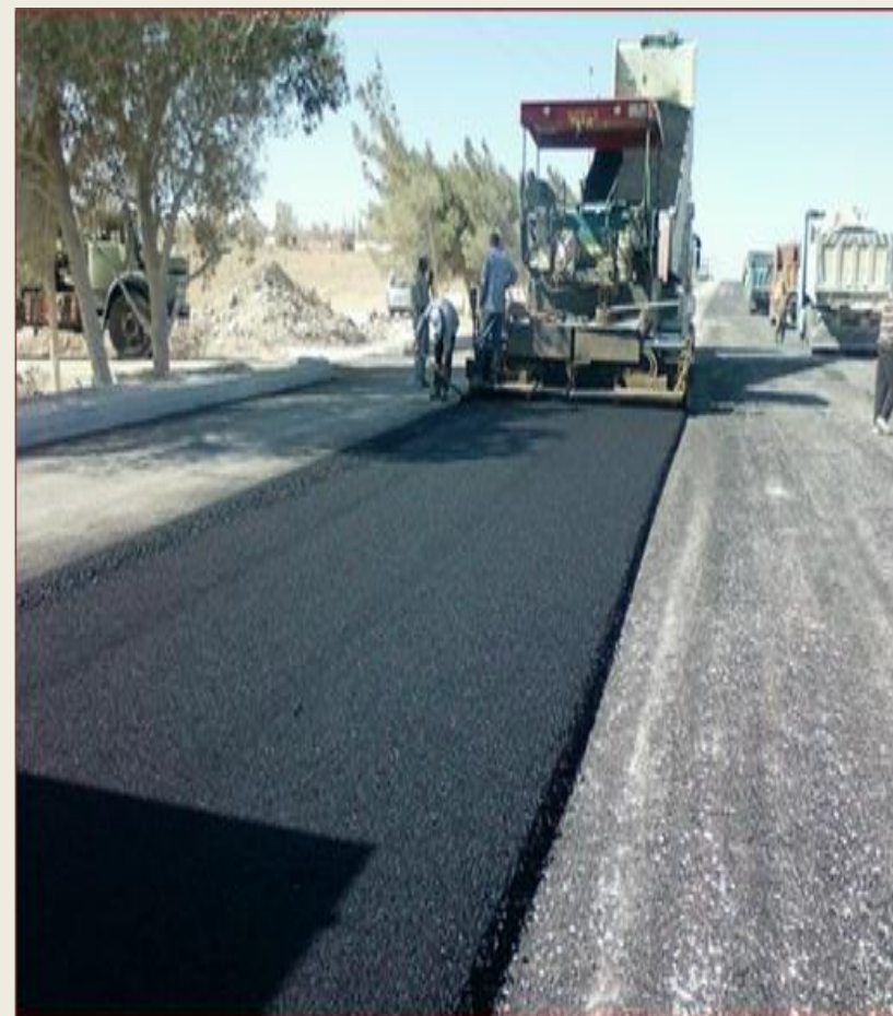
طريق الكرك ( القصر - الموجب ) المحطة : ١٣٠+١١ أعمال خلطة إسفلتية ١٩ / ٧ / ٢٠١١
